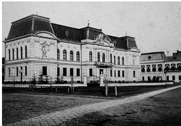
Historická účelová budova múzea začiatkom 20. storočia
